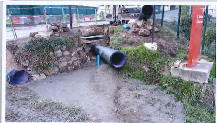
Enfouissement réseau télécom et pluvial
