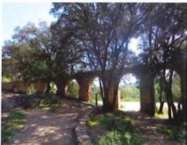
Pont des 25 arches à Roquebrune
