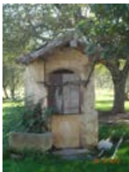
Puit de Trestaure
