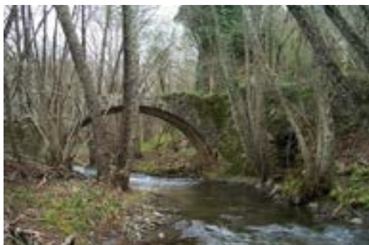
Pont sur l'Endre
