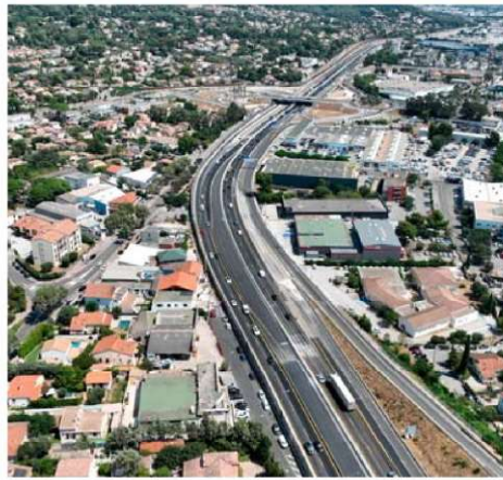
Encore un peu de patience pour profiter pleinement de l'élargissement à deux fois trois voies de l'autoroute urbaine. PHOTO DR
