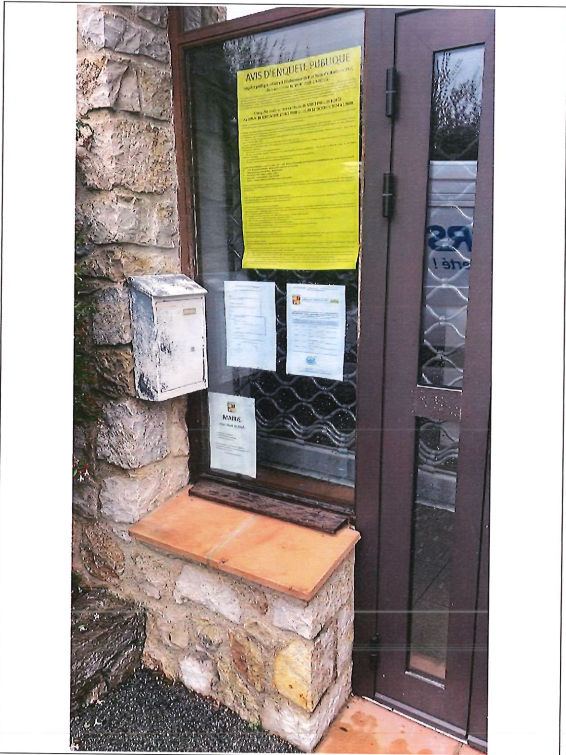
Fichier : 17-10-2024 mairie.jpg Remonté le : 18/10/2024 10:47
